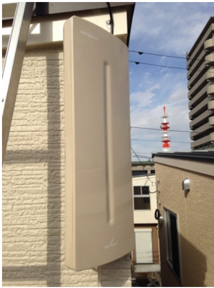
川越市新宿町 ポラス様物件 壁面取付 デザインアンテナ工事
