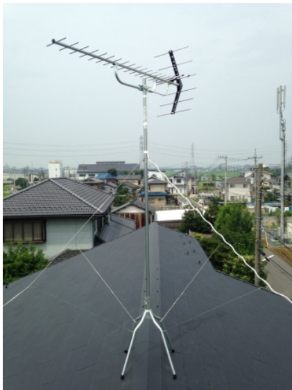
川越市今成 アイフルホーム様物件 地デジアンテナ屋根上工事
