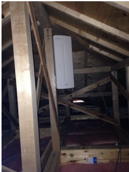
川越市新宿町 タクトホーム様物件 デザインアンテナ屋根裏工事
