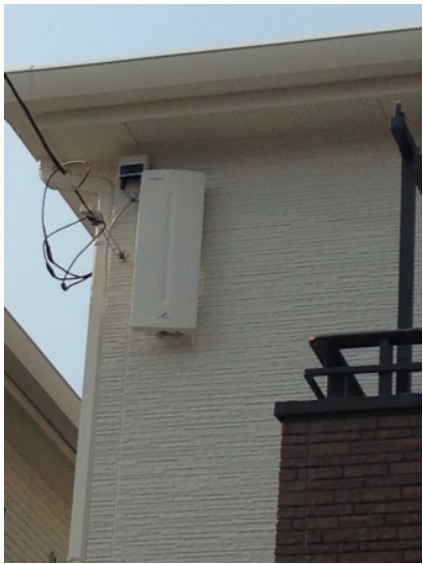
川崎市山田 住協建設様物件 壁面取付 デザインアンテナ工事
