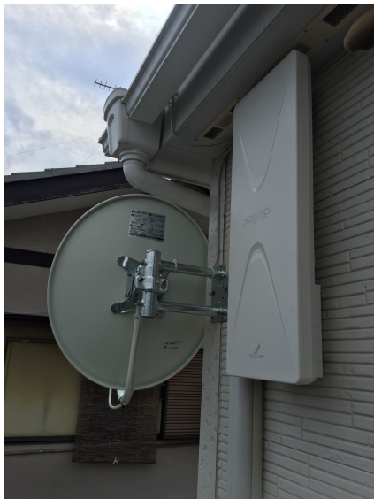
川越市今福 壁面取付 デザインアンテナとBSアンテナ工事
