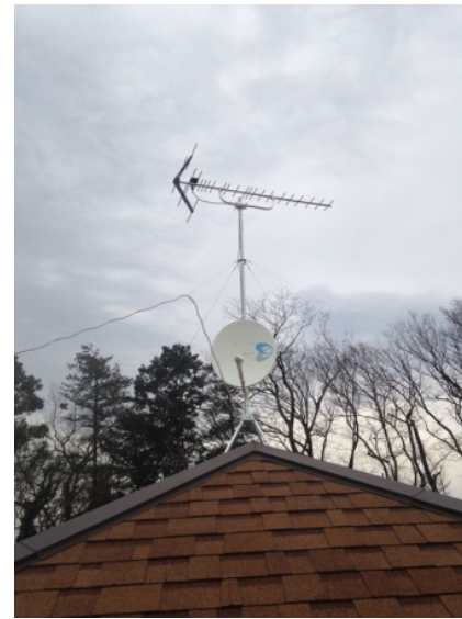
川越市下松原 ケイアイスター不動産様物件 地デジアンテナとBSアンテナ屋根上工事
