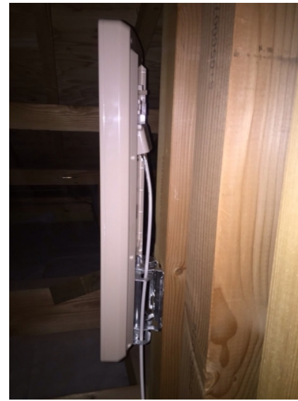
川越市上戸 タマホーム様物件 デザインアンテナ屋根裏工事
