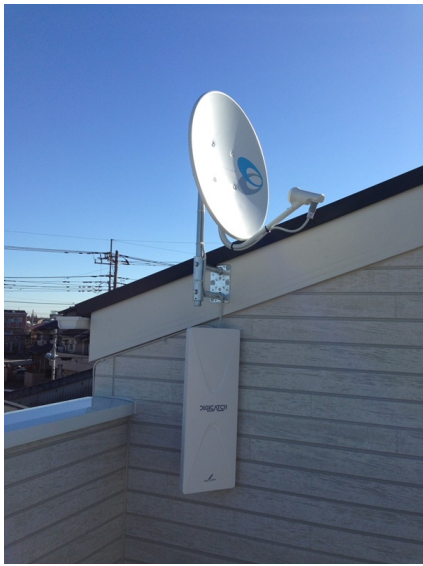
越谷市南町 アペルト様物件 壁面取付 デザインアンテナとBSアンテナ工事
