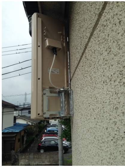
越谷市下間久里 アーネストワン様物件 壁面取付 デザインアンテナ工事
