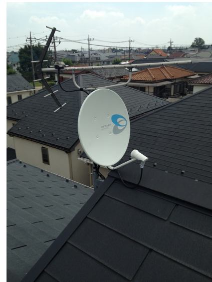
越谷市東大沢 ポラス様物件 BSアンテナ追加 工事
