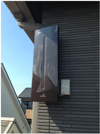
越谷市平方 松家住宅様物件 壁面取付 デザインアンテナ工事
