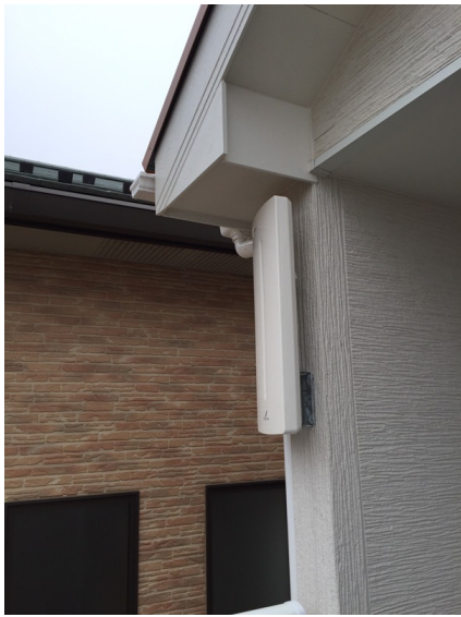
越谷市東越谷 一建設様物件 壁面取付 デザインアンテナ工事
