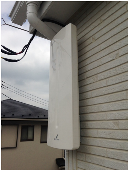
越谷市千間台西 壁面取付 デザインアンテナ工事
