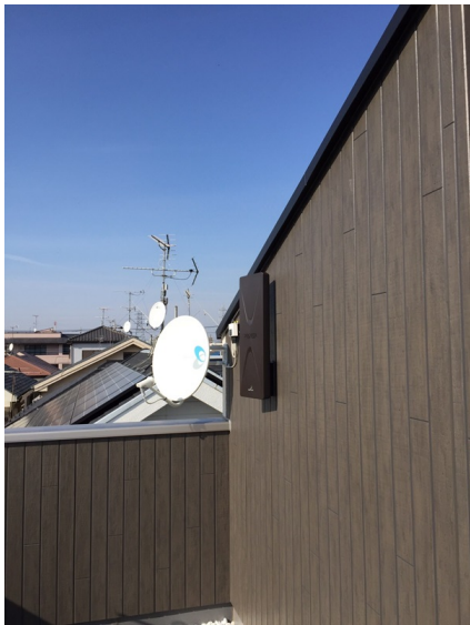
越谷市登戸町 レクスターリビング様物件 壁面取付 デザインアンテナとBSアンテナ工事
