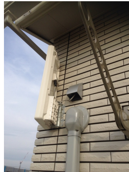
越谷市東町 一条工務店様物件 壁面取付 デザインアンテナ工事
