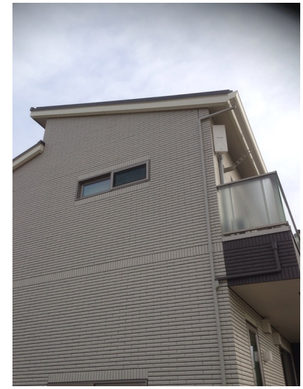
越谷市東町 一条工務店様物件 デザインアンテナ工事後の外観
