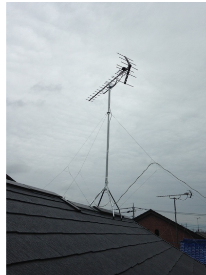
越谷市袋山 トータルエステート様物件 地デジアンテナ屋根上工事
