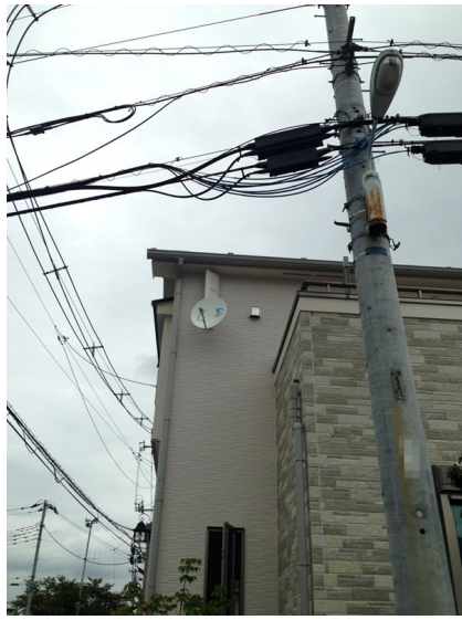
越谷市大道 ポラス様物件 壁面取付 デザインアンテナとBSアンテナ工事
