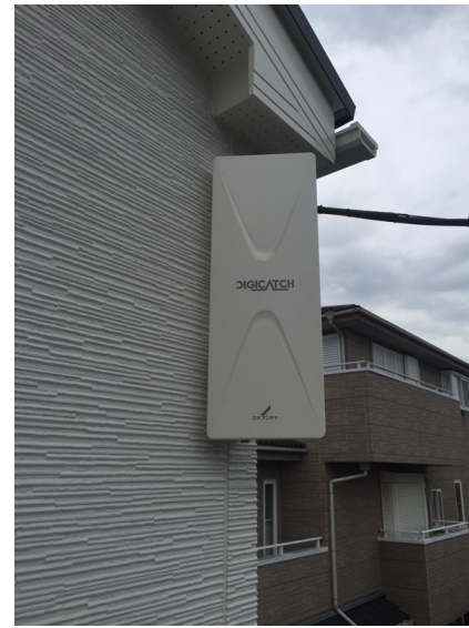
越谷市北越谷 ワンズオンハウス様物件 壁面取付 デザインアンテナ工事
