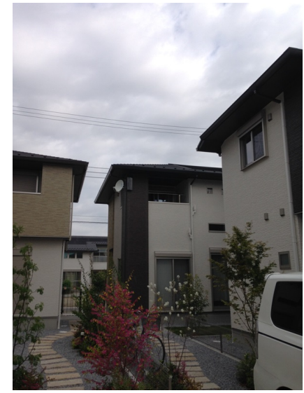
越谷市レイクタウン タカラレーベン様物件 デザインアンテナとBSアンテナ工事後の外観
