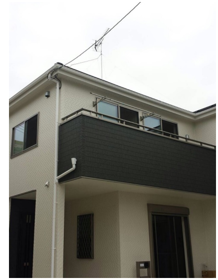
越谷市南町 アペルト様物件 地デジアンテナ工事後の外観
