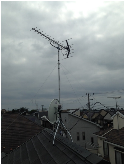
越谷市大林 城南建設様物件 地デジアンテナとBSアンテナ屋根上工事
