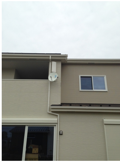
越谷市七左町 東栄住宅様物件 デザインアンテナとBSアンテナ工事後の外観
