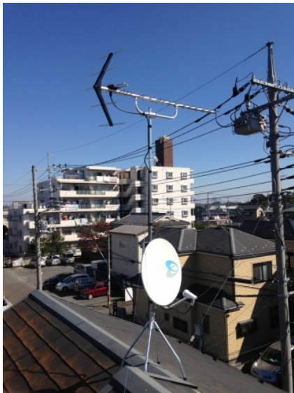
川越市岸町 地デジアンテナとB Sアンテナ屋根上工事
