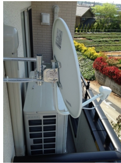
川越市今福 壁面取付 BSアンテナ工事
