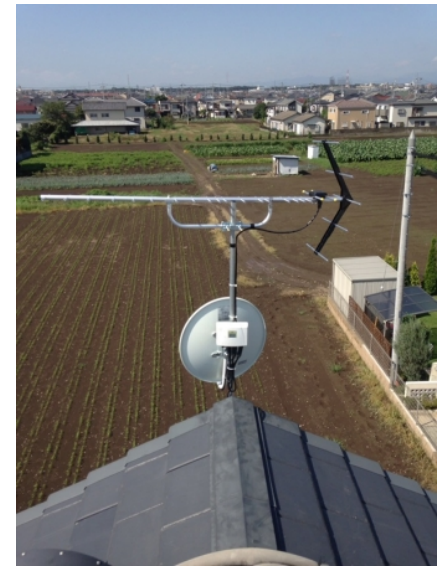
川越市笠幡 壁面取付 地デジアンテナとBSアンテナ工事
