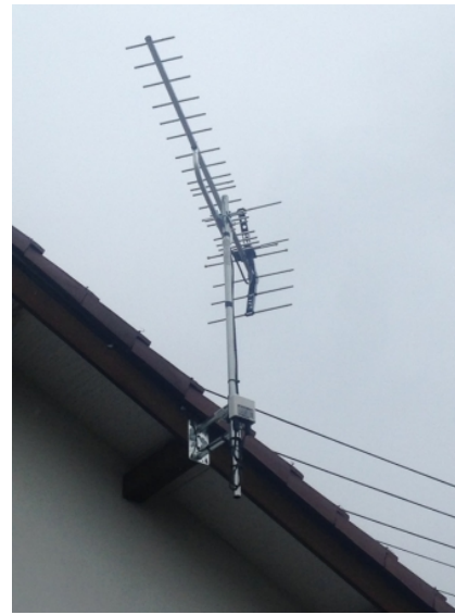
川越市府川 壁面取付 地デジアンテナ工事
