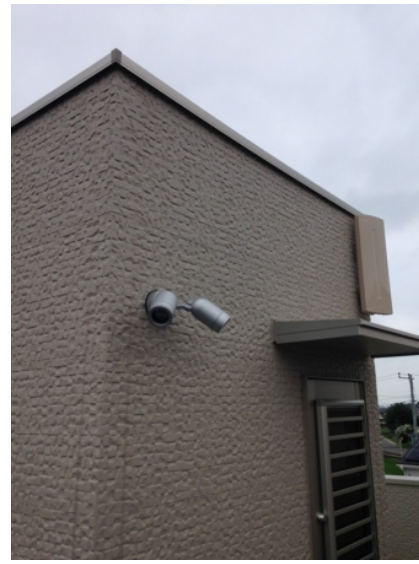
川越市牛子 壁面取付 デザインアンテナ工事
