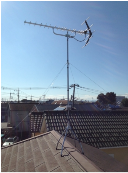
川越市山田 地デジアンテナ屋根上工事
