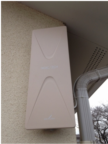
川越市市場 壁面取付 デザインアンテナ工事
