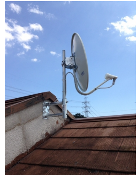
川越市寺尾 壁面取付 BSアンテナ工事
