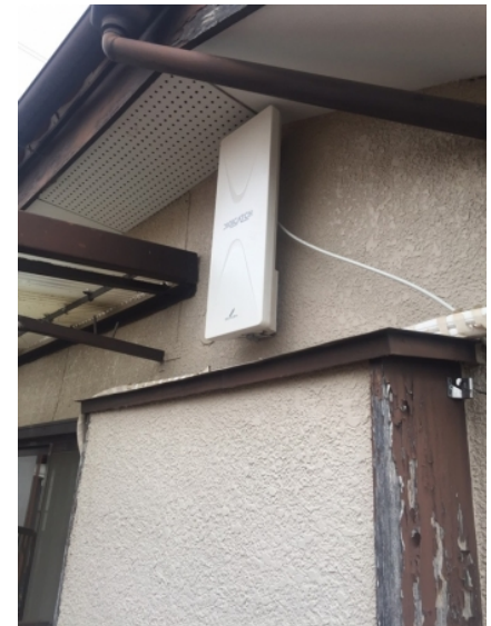
川越市豊田町 壁面取付 デザインアンテナ工事
