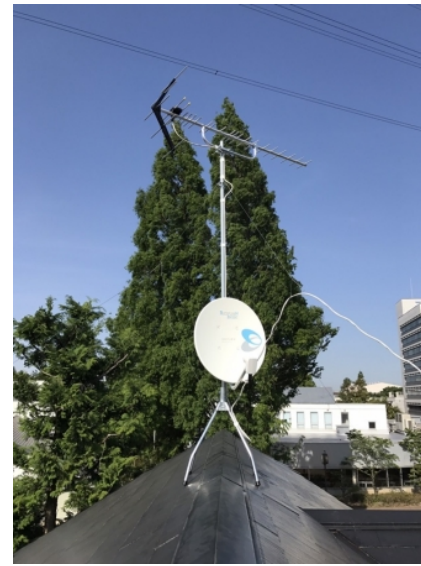
川越市市場 地デジアンテナとBSアンテナ屋根上工事
