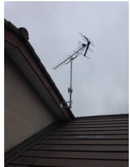
川越市小ヶ谷 壁面取付 地デジアンテナ工事
