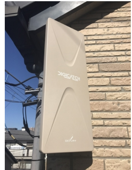
川越市富士見町 壁面取付 デザインアンテナ工事
