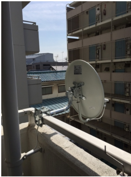
川越市脇田本町 ベランダ取付 B Sアンテナ 工事
