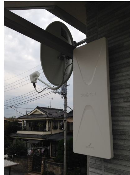
川越市寺尾 近藤建設様物件 壁面取付 デザインアンテナとBSアンテナ工事
