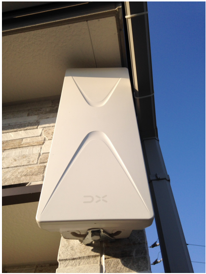
川越市むさし野 住宅情報館様ご物件 壁面取付 デザインアンテナ工事
