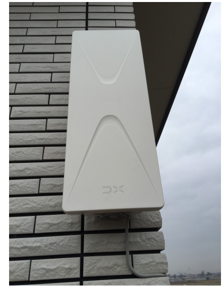
川越市山田 一条工務店様ご物件 壁面取付 デザインアンテナ工事
