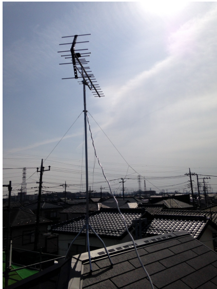
川越市南大塚 屋根上設置 八木式アンテナ工事
