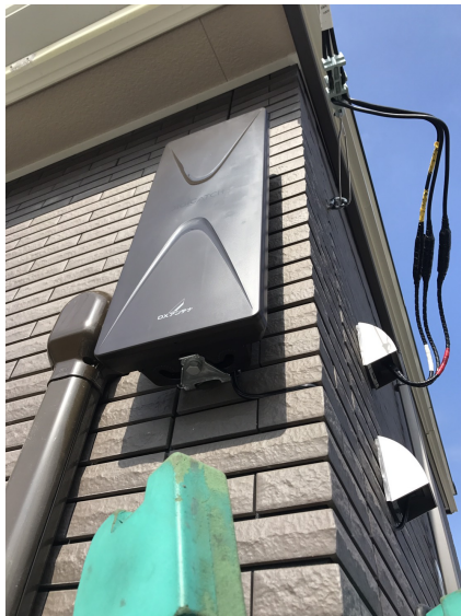
川越市中台元町 一条工務店様ご物件 壁面取付 デザインアンテナ工事
