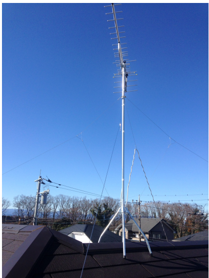
川越市豊田町 屋根上設置 八木式アンテナ工事
