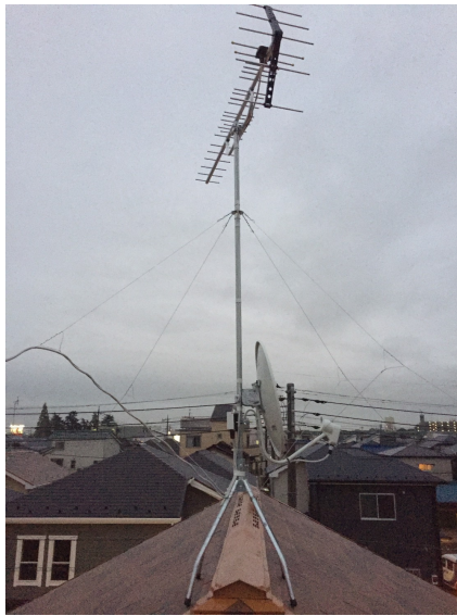
川越市岸町 住協建設様物件 地デジアンテナとBSアンテナ屋根上工事
