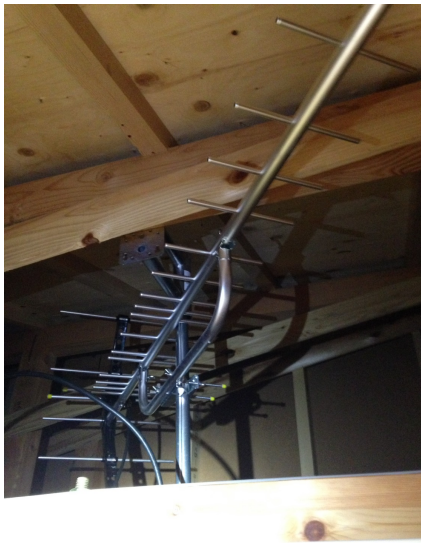
川越市仙波町 リリーフイチマルイチ様物件 屋根裏設置 地デジアンテナ工事
