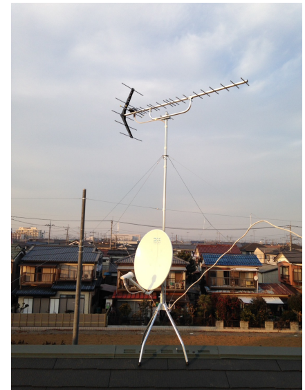
川越市月吉町 日商建設様ご物件 屋根上設置 八木式アンテナとBS/CSアンテナ工事
