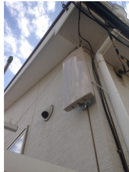
入間郡三芳町藤久保 壁面取付 デザインアンテナ工事
