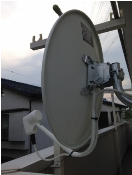
入間郡三芳町藤久保 壁面取付 BSアンテナ工事
