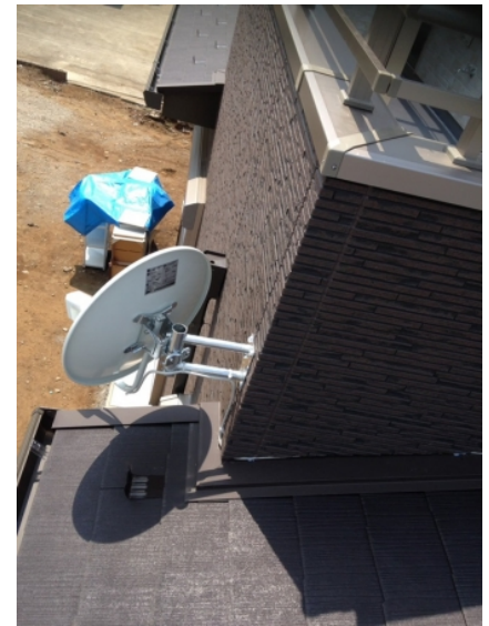
入間郡三芳町竹間沢 住協建設様物件 壁面取付 BSアンテナ工事
