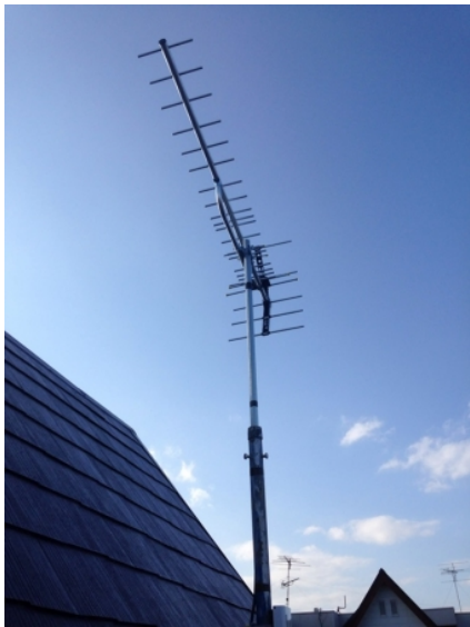
入間郡三芳町藤久保 ポール取付 地デジアンテナ工事
