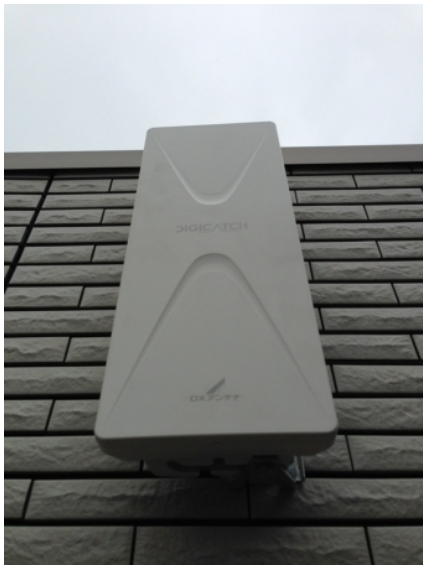
川口市差間 一条工務店様物件 壁面取付 デザインアンテナ工事
