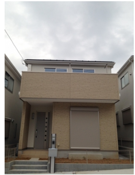
川口市東本郷 デザインアンテナ工事後の外観
