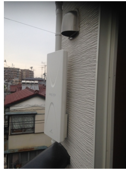
川口市前川町 三建アーキテクト様物件 壁面取付 デザインアンテナ工事
