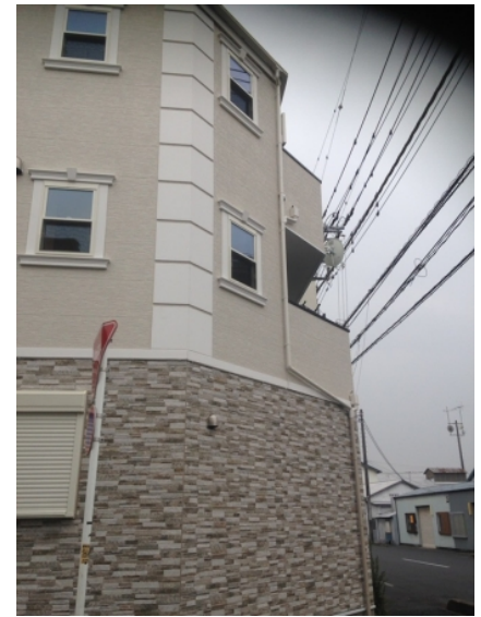
川口市前川町 三建アーキテクト様物件 デザインアンテナとBSアンテナ工事後の外観
