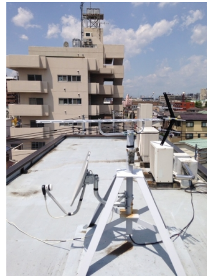
川口市並木 アドバンスホーム様物件 地デジアンテナ追加工事
