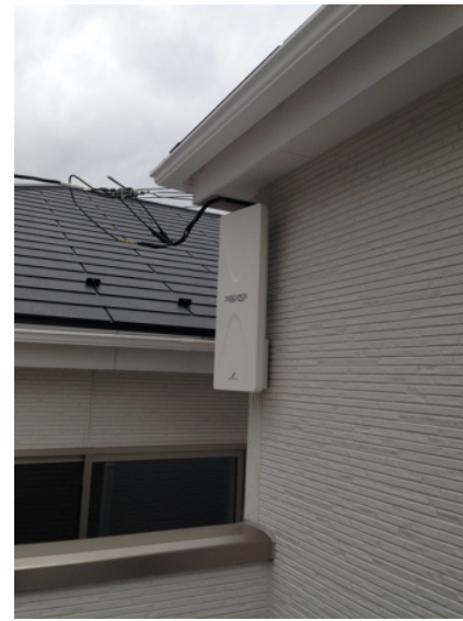
川口市東本郷 壁面取付 デザインアンテナ工事
