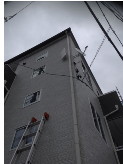
川口市飯塚 ララホーム様物件 壁面取付 デザインアンテナとBSアンテナ工事
