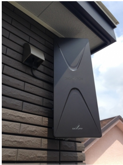
川口市朝日 一条工務店様物件 壁面取付 デザインアンテナ工事
