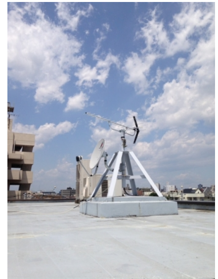
川口市並木 アドバンスホーム様物件 地デジアンテナ追加工事
