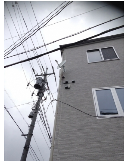
川口市飯塚 ララホーム様物件 壁面取付 デザインアンテナとBSアンテナ工事
