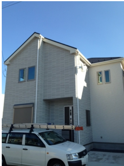
川口市長蔵 東栄住宅様物件 デザインアンテナとBSアンテナ工事後の外観
