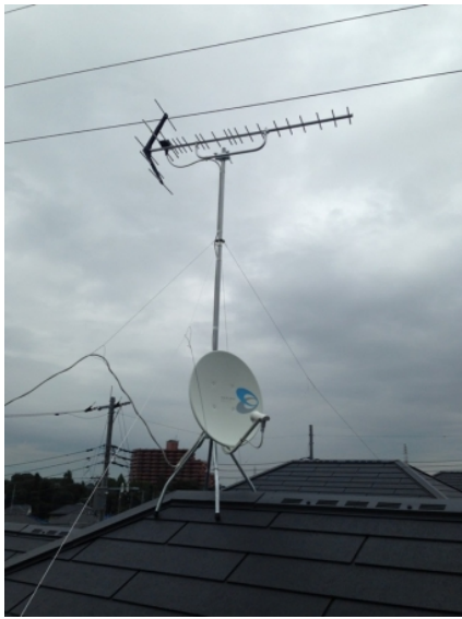
川口市東内野 地デジアンテナとBSアンテナ屋根上工事
