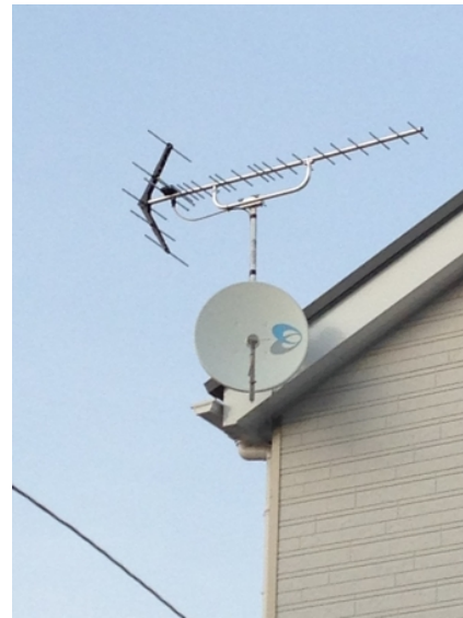
川口市八幡木 アーネストワン様物件 壁面取付 地デジアンテナとBSアンテナ工事
