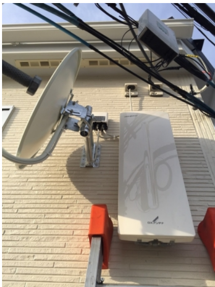
川口市藤兵衛新田 壁面取付 デザインアンテナとBSアンテナ工事
