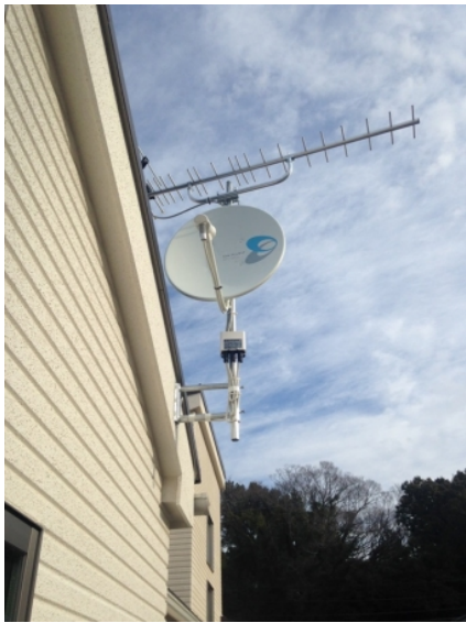
川口市芝塚原 プレストホーム様物件 壁面取付 地デジアンテナとBSアンテナ工事
