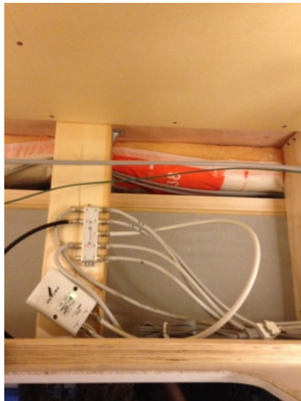
川口市仲町 アイムユニバース様物件 ブースター電源部 8分配器
