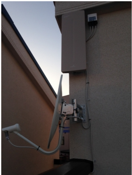
川口市仲町 アイムユニバース様物件 壁面取付 デザインアンテナとBSアンテナ工事
