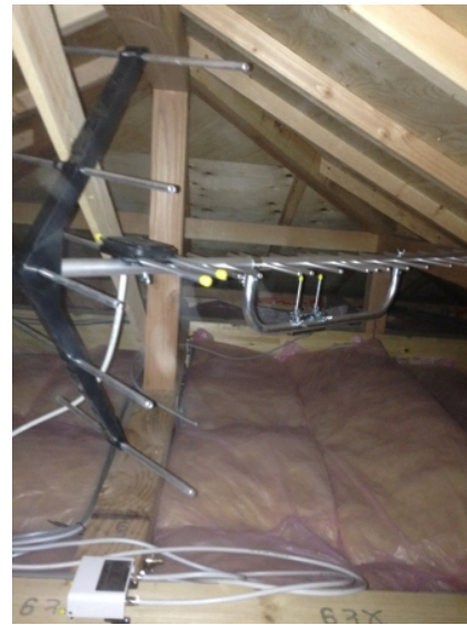
川口市安行原 一建設様物件 地デジアンテナ屋根裏工事
