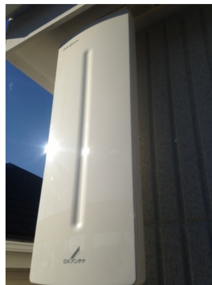
川口市神戸 壁面取付 デザインアンテナ工事
