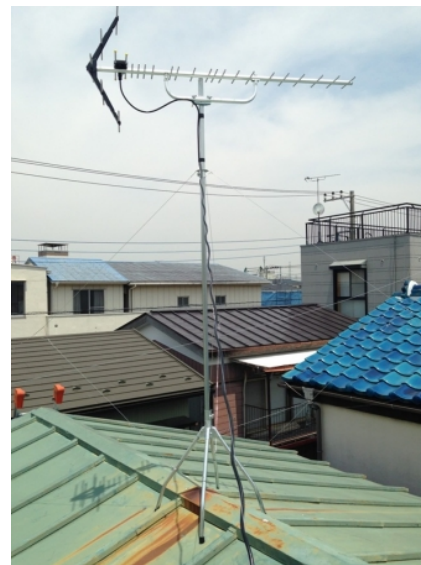
川口市芝下 大和不動産様物件 地デジアンテナ屋根上工事
