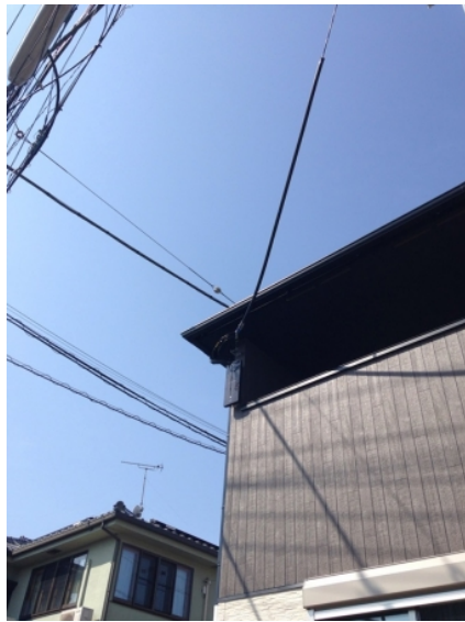
川口市西立野 ポラス様物件 デザインアンテナ工事後の外観
