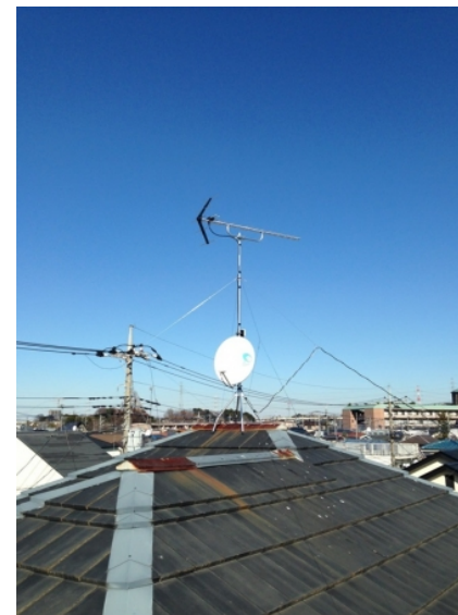
川口市鳩ヶ谷本町 中央住宅様物件 地デジアンテナとB Sアンテナ屋根上工事
