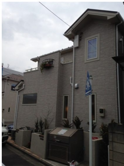
川口市東領家 ポラス様物件 デザインアンテナ工事後の外観
