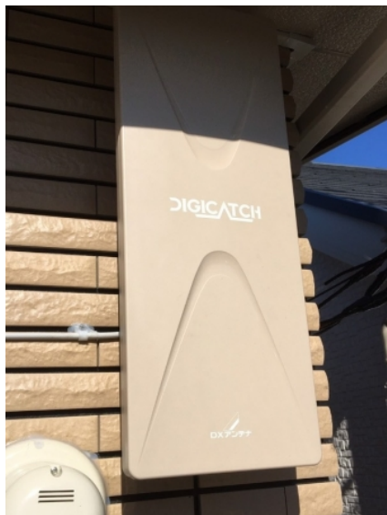
川口市本前川 一条工務店様物件 壁面取付 デザインアンテナ工事
