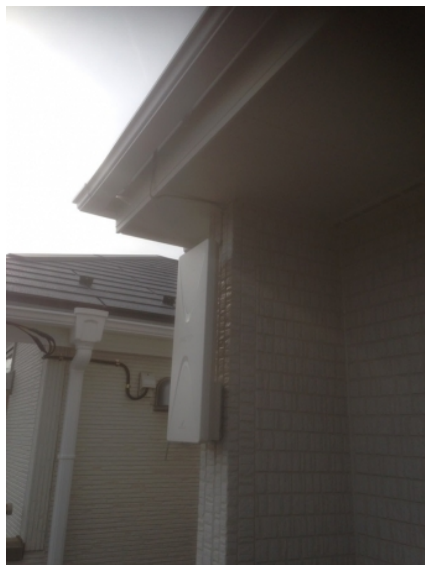
川口市鳩ヶ谷本町 一建設様物件 壁面取付 デザインアンテナ工事
