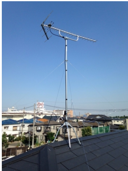
川口市安行領家 一建設様物件 地デジアンテナ屋根上工事
