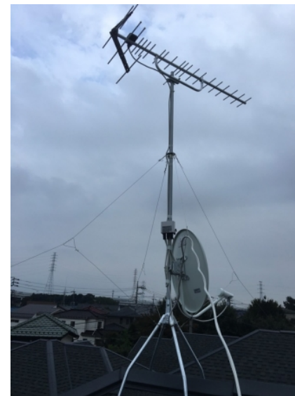
川口市木曽呂 飯田産業様物件 地デジアンテナとBSアンテナ屋根上工事
