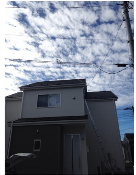
川口市安行吉岡 IDホーム様物件 地デジアンテナ工事後の外観
