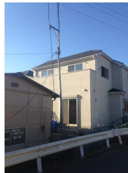
川口市神戸 デザインアンテナ工事後の外観
