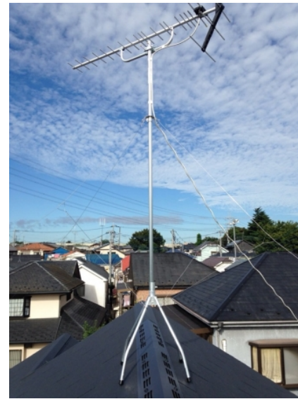
川口市安行吉岡 IDホーム様物件 地デジアンテナ屋根上工事
