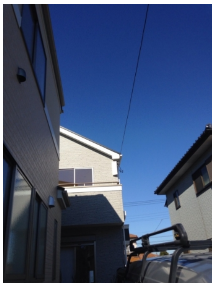
川口市戸塚境町 飯田産業様物件 デザインアンテナ工事後の外観
