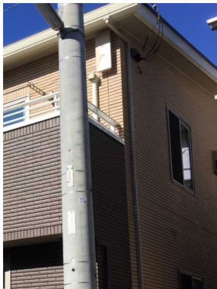
川口市本前川 一条工務店様物件 デザインアンテナ工事後の外観
