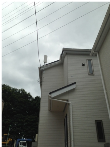
川口市神戸 飯田産業様物件 デザインアンテナ工事後の外観
