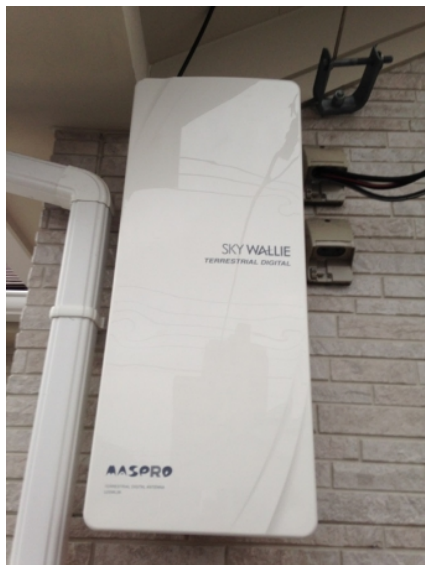
川口市東領家 ポラス様物件 壁面取付 デザインアンテナ工事
