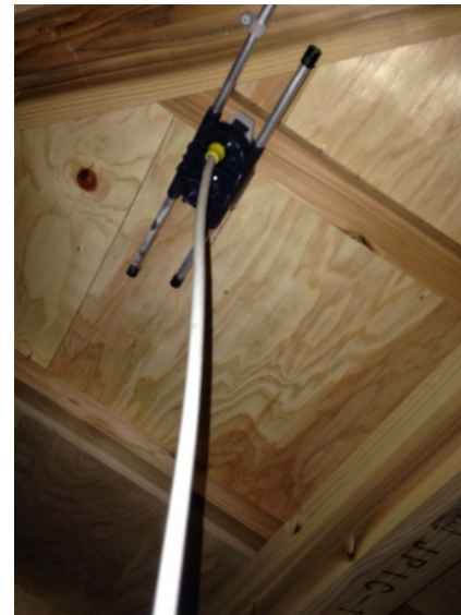
川口市江戸 城南建設様物件 地デジアンテナ屋根裏工事
