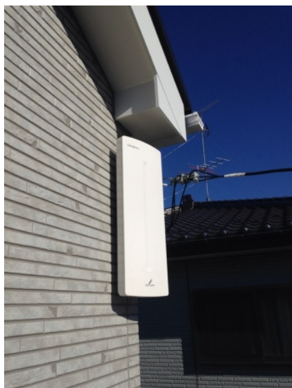
川口市戸塚境町 飯田産業様物件 壁面取付 デザインアンテナ工事
