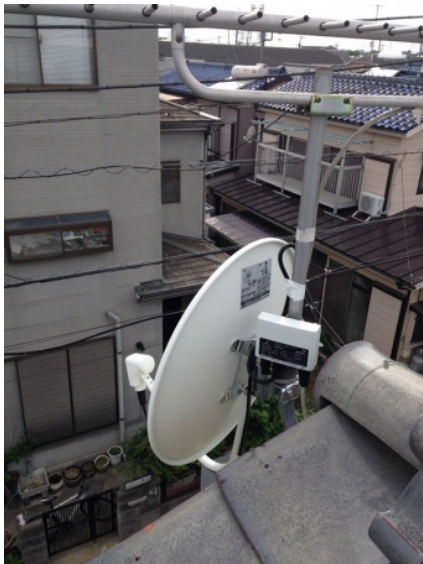
川口市榛松 BSアンテナ追加工事
