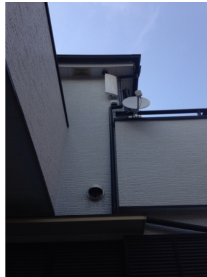
川口市安行領家 壁面取付 デザインアンテナ工事
