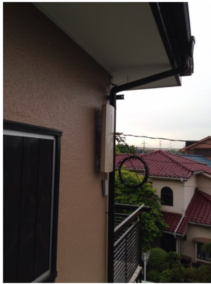
川口市前野宿 壁面取付 デザインアンテナ工事
