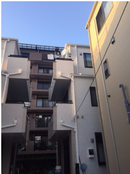
川口市前上町 デザインアンテナとBSアンテナ工事後の外観
