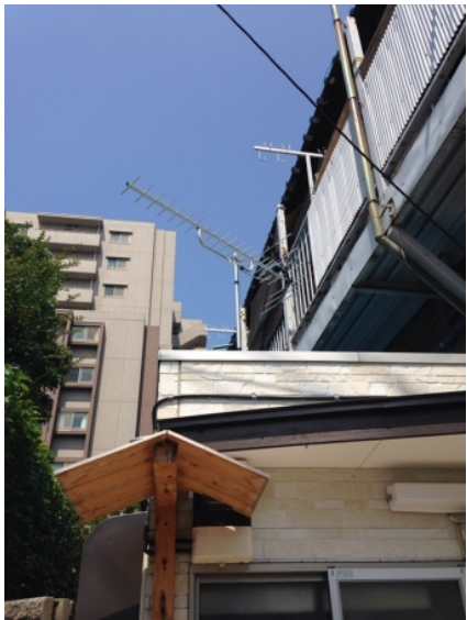
川口市辻 壁面取付 地デジアンテナ工事
