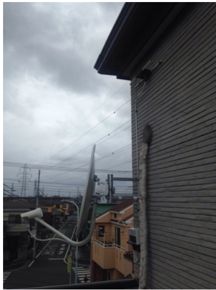
川口市南鳩ヶ谷 壁面取付 地デジアンテナとBSアンテナ工事
