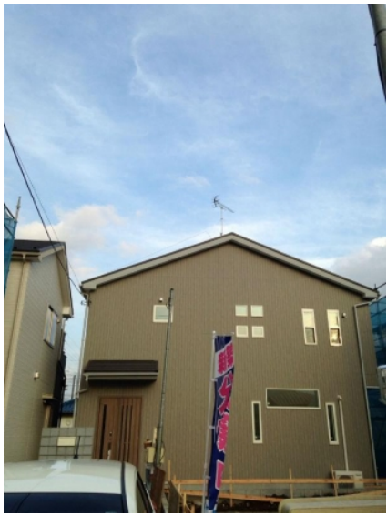
川口市里 地デジアンテナ工事後の外観
