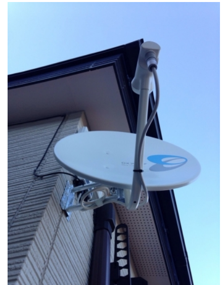
川口市末広 壁面取付 BSアンテナ工事
