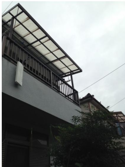
川口市差間 デザインアンテナ工事後の外観
