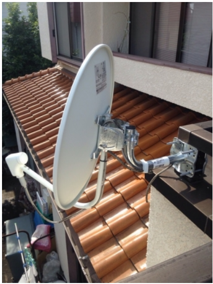
川口市東本郷 ペランダ取付 BSアンテナ工事
