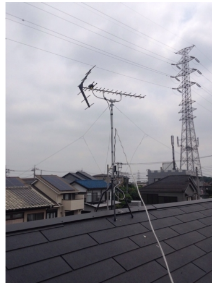
川口市東本郷 アンテナ方向調整前
