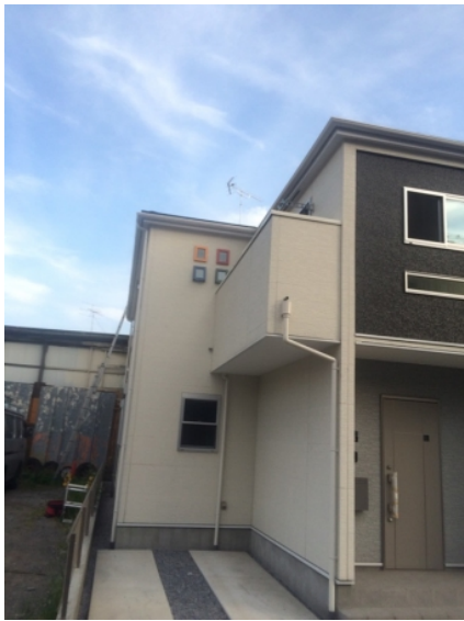
川口市上青木 地デジアンテナ工事後の外観
