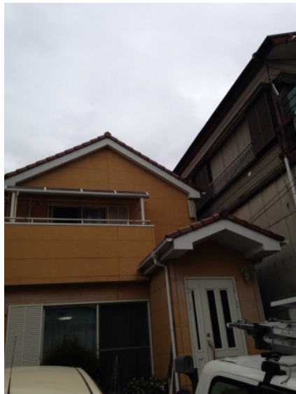
川口市上青木西 デザインアンテナ工事後の外観
