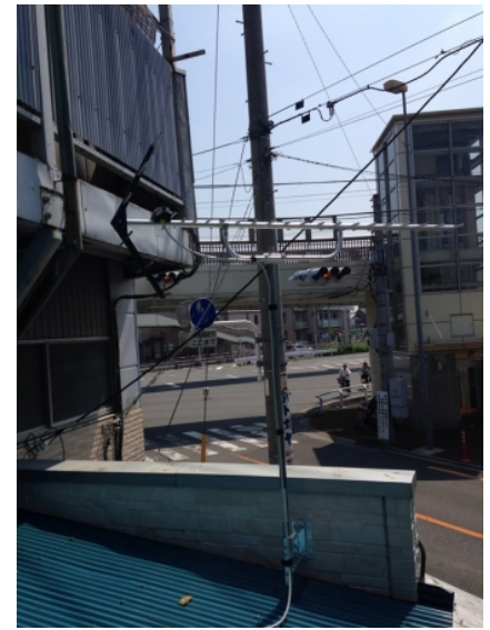
川口市辻 壁面取付 地デジアンテナ工事
