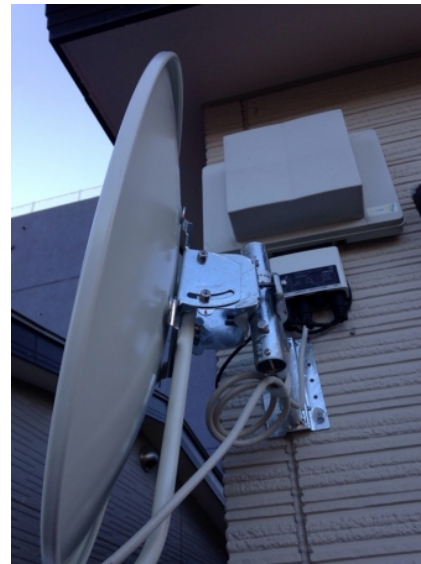
川口市末広 壁面取付 BSアンテナ工事
