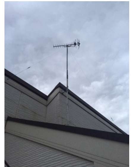
川口市木曽呂 地デジアンテナ追加工事
