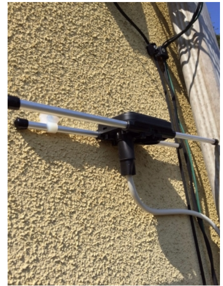
川口市芝 壁面取付 地デジアンテナ工事
