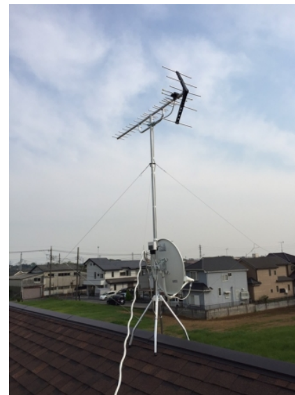
上尾市西宮下 ケイアイスター不動産様物件 地デジアンテナとBSアンテナ屋根上工事
