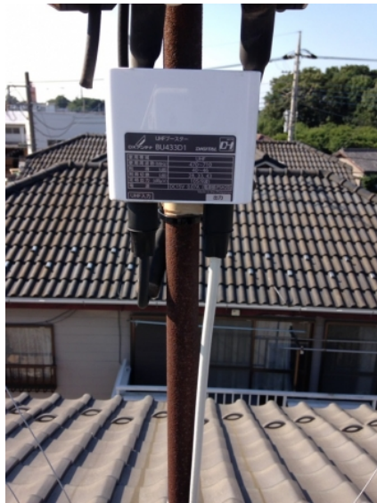
上尾市平塚 ブースター交換工事
