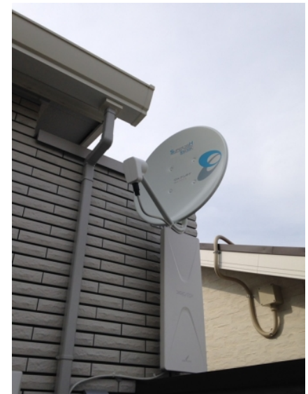
上尾市久保 一条工務店様物件 壁面取付 デザインアンテナとBSアンテナ工事
