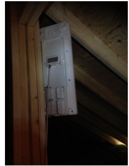
上尾市向山 ポラス様物件 デザインアンテナ屋根裏工事
