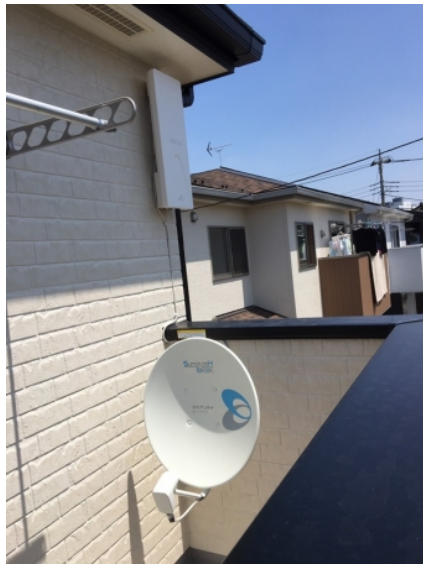
上尾市地頭方 城南建設様物件 壁面取付 デザインアンテナとBSアンテナ工事
