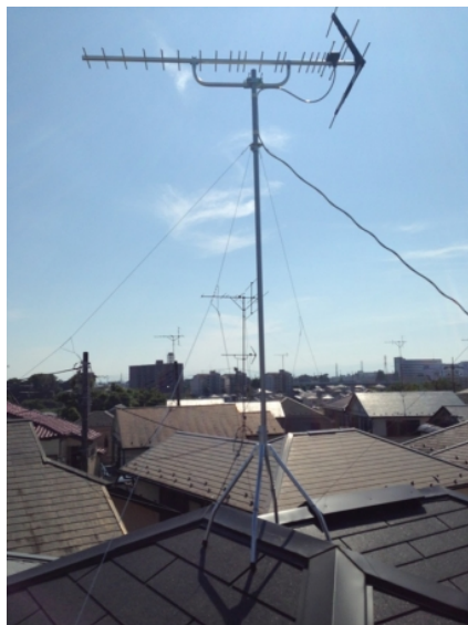
上尾市原市 アベルト様物件 地デジアンテナ屋根上工事
