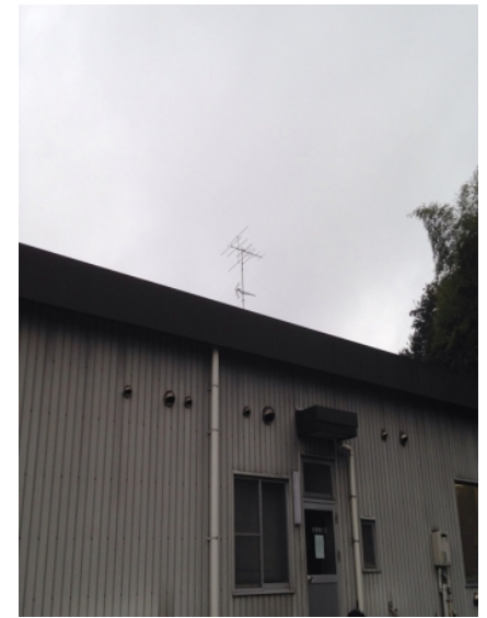
上尾市平方 地デジアンテナ工事後の外観
