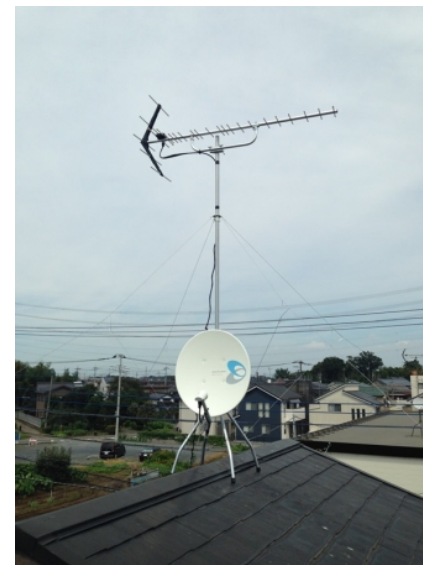
上尾市上 大成建設様物件 地デジアンテナとBSアンテナ屋根上工事
