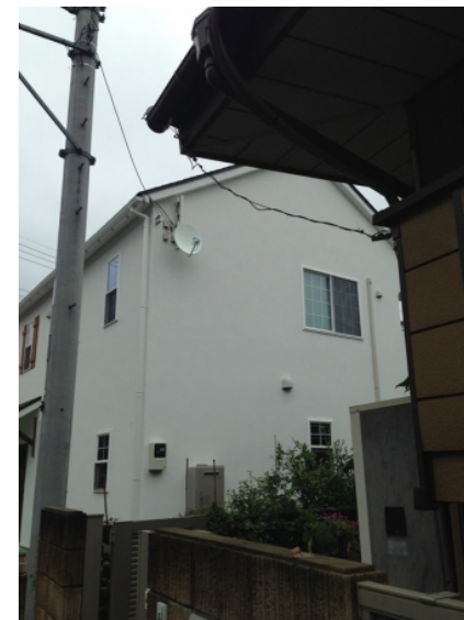
上尾市原市 アットナチュレ様物件 デザインアンテナとBSアンテナ工事後の外観
