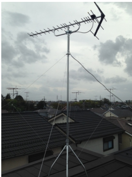
上尾市瓦葺 昭栄建設様物件 地デジアンテナ屋根上工事
