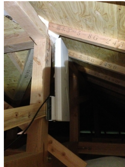
上尾市向山 コタエルハウス様物件 デザインアンテナ屋根裏工事
