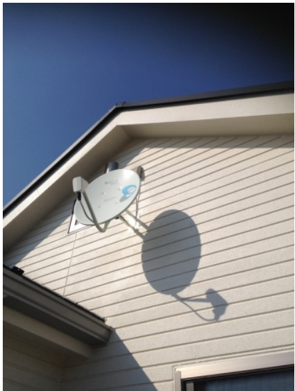
上尾市向山 ポラス様物件 壁面取付 BSアンテナ工事
