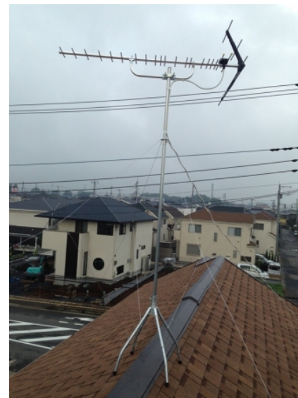
上尾市小泉 地デジアンテナ屋根上工事
