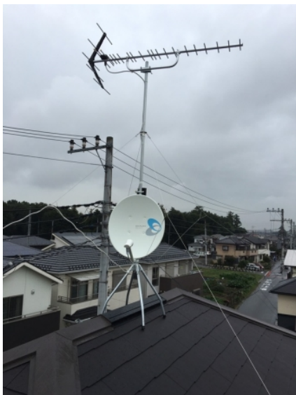
上尾市小泉 ミサワホーム様物件 地デジアンテナとBSアンテナ屋根上工事
