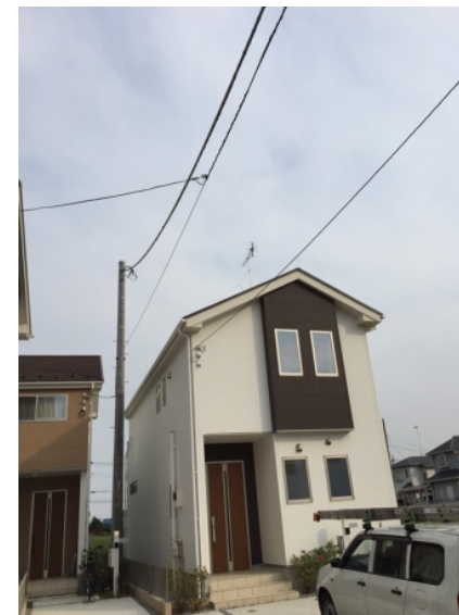
上尾市西宮下 ケイアイスター不動産様物件 地デジアンテナとBSアンテナ工事後の外観
