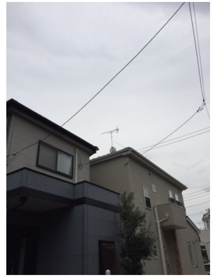
上尾市原市 一建設様物件 地デジアンテナとBSアンテナ屋根上工事
