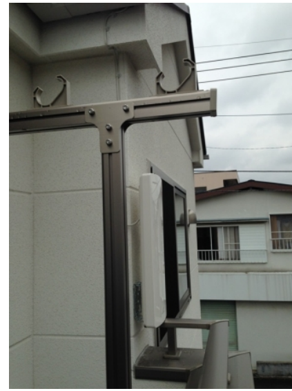
上尾市上 タクトホーム様物件 壁面取付 デザインアンテナ工事
