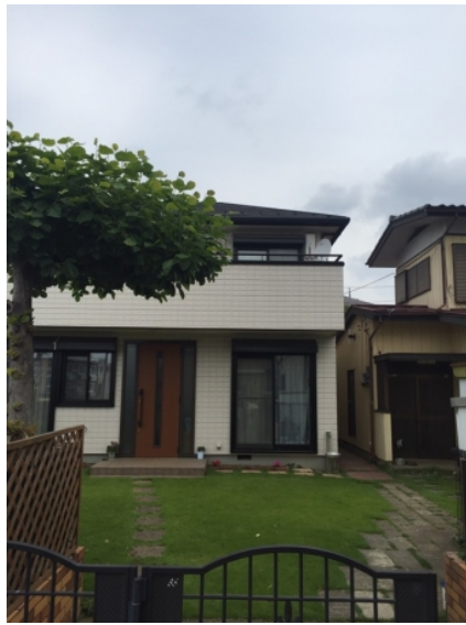
上尾市小泉 旭化成様物件 デザインアンテナ工事後の外観
