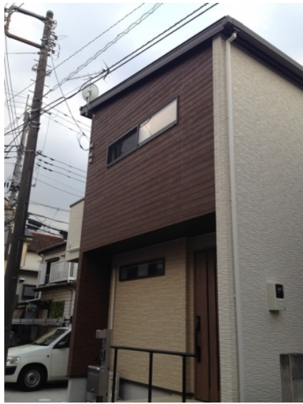
上尾市原市 永大様物件 地デジアンテナとBSアンテナ工事後の外観
