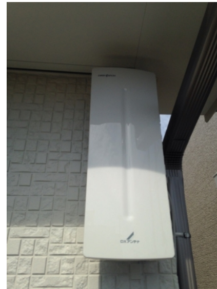
上尾市瓦葺 富士住建様物件 壁面取付 デザインアンテナ工事
