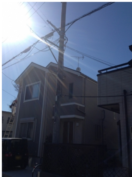
上尾市小泉 サンシティホーム様物件 地デジアンテナとBSアンテナ工事後の外観
