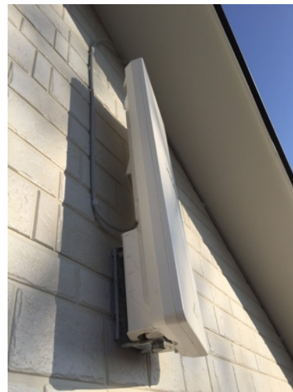
上尾市小泉 飯田産業様物件 壁面取付 デザインアンテナ工事
