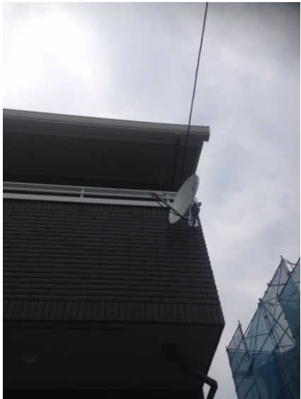
上尾市大谷本郷 一条工務店様物件 BSアンテナ工事後の外観
