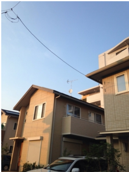
上尾市上尾村 ダイワハウス様物件 地デジアンテナとBSアンテナ工事後の外観
