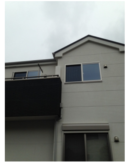
上尾市上 タクトホーム様物件 デザインアンテナ工事後の外観
