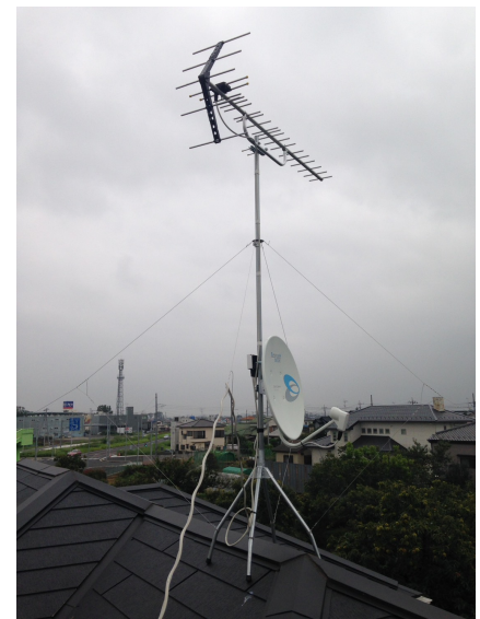
上尾市小敷谷 BSアンテナ追加工事
