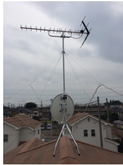
上尾市原市 一建設様物件 地デジアンテナとBSアンテナ屋根上工事
