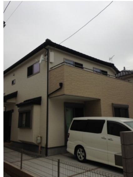
上尾市富士見 三國ホーム様物件 デザインアンテナとBSアンテナ工事後の外観
