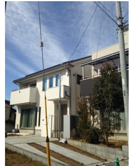
上尾市瓦葺 富士住建様物件 デザインアンテナ工事後の外観
