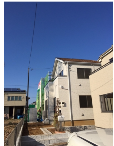
上尾市小泉 飯田産業様物件 デザインアンテナ工事後の外観
