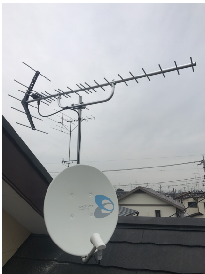
上尾市瓦葺 地デジアンテナとBSアンテナ工事
