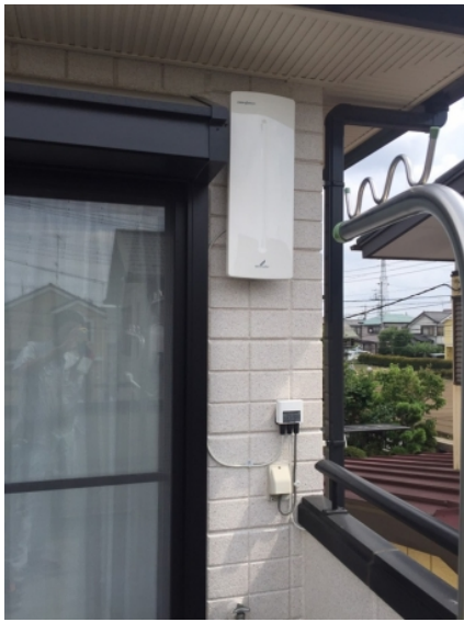
上尾市小泉 旭化成様物件 壁面取付 デザインアンテナ工事
