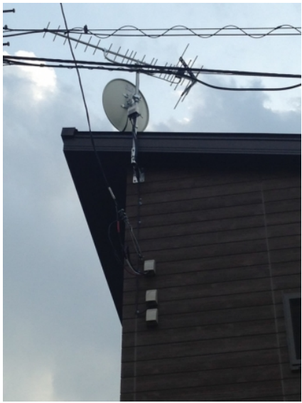
上尾市原市 永大様物件 壁面取付 地デジアンテナとBSアンテナ工事
