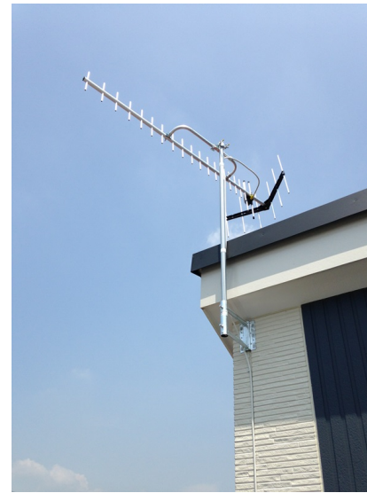
厚木市愛甲 垂直偏波受信 壁面取付 地デジアンテナ工事
