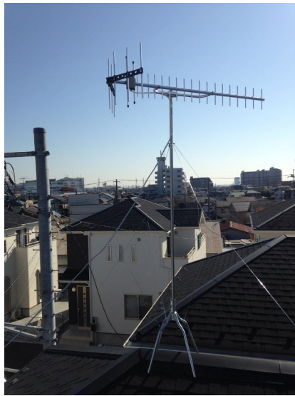
厚木市温水 垂直偏波受信 地デジアンテナ屋根上工事
