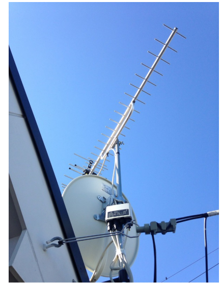
厚木市水引 壁面取付 地デジアンテナとBSアンテナ工事
