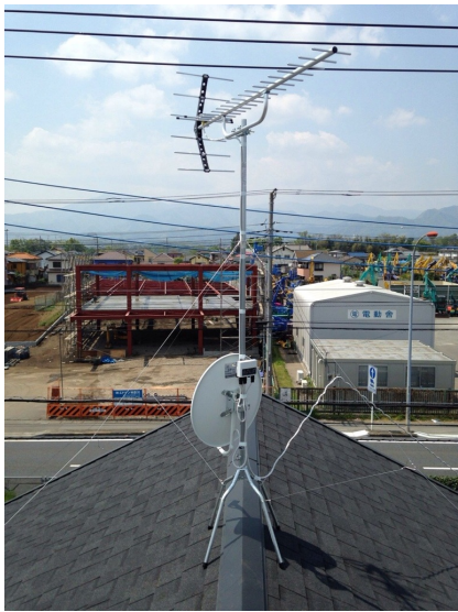
厚木市関口 地デジアンテナとBSアンテナ屋根上工事
