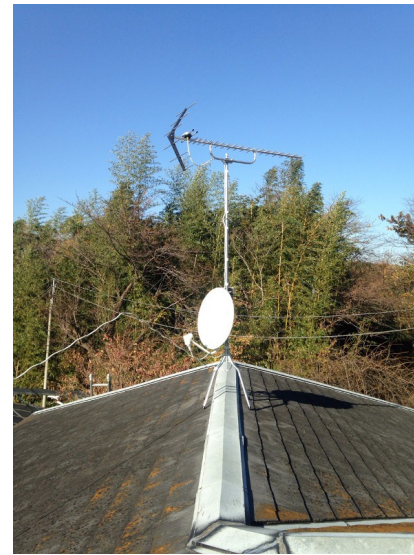
厚木市長谷 地デジアンテナとBSアンテナ屋根上工事
