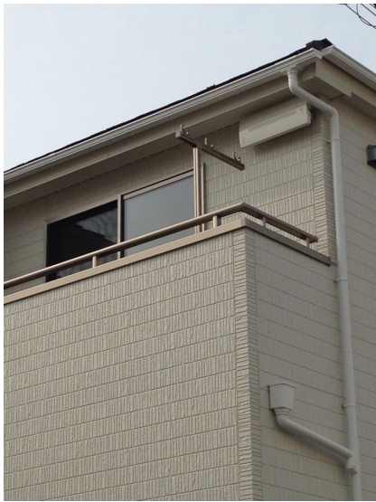
厚木市温水 垂直偏波受 壁面取付 デザインアンテナ工事
