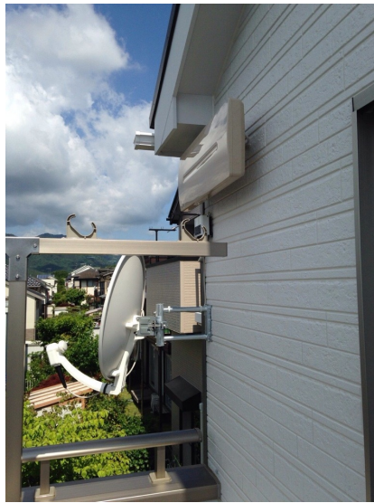
厚木市まつかけ台 垂直偏波受信 壁面取付 デザインアンテナとBSアンテナ工事
