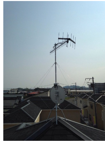
厚木市温水 垂直偏波受信 地デジアンテナとBSアンテナ屋根上工事
