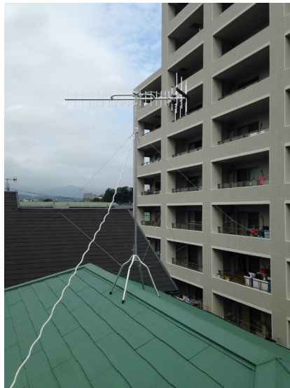
厚木市関口 屋根上設置 地デジアンテナ工事
