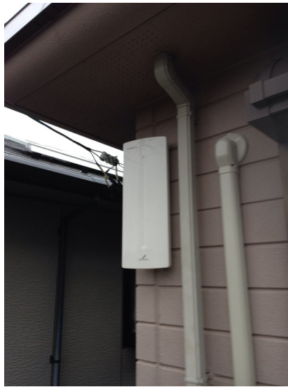
厚木市金田 デザインアンテナ工事後の外観
