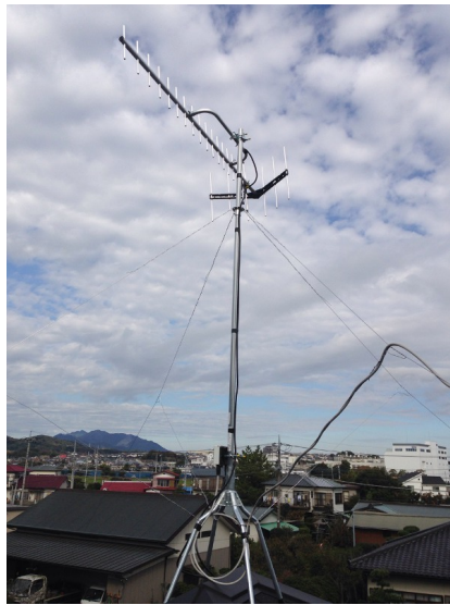
厚木市山際 垂直偏波受信 垂直偏波受信 地デジアンテナ屋根上工事
