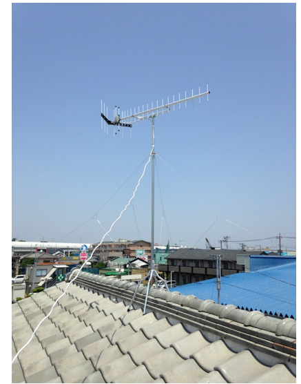
厚木市三田南 垂直偏波受信 屋根上設置 地デジアンテナ工事
