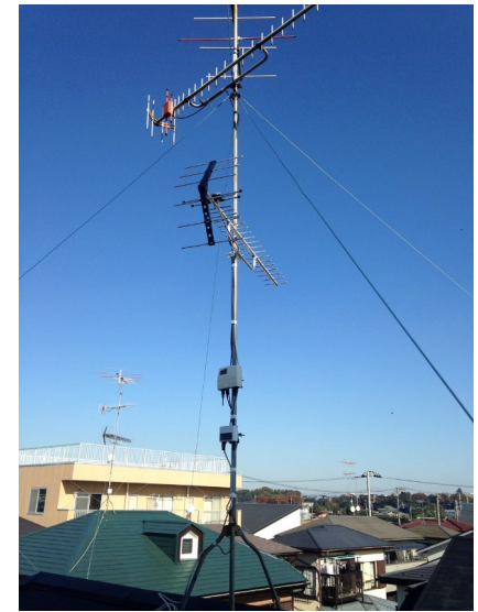
厚木市温水 地デジアンテナ追加工事
