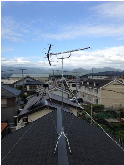
厚木市恩名 垂直偏波受信 地デジアンテナ屋根上工事
