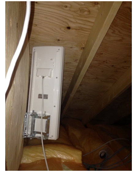
厚木市温水西 イトーピアホーム様ご物件 デザインアンテナ屋根裏工事
