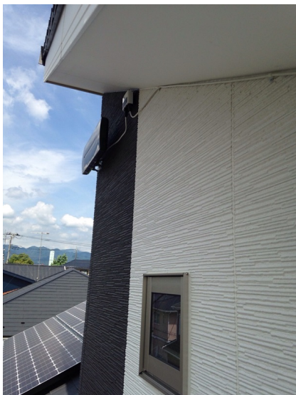
厚木市妻田北 富士住建様ご物件 垂直偏波受信 壁面取付 デザインアンテナ工事
