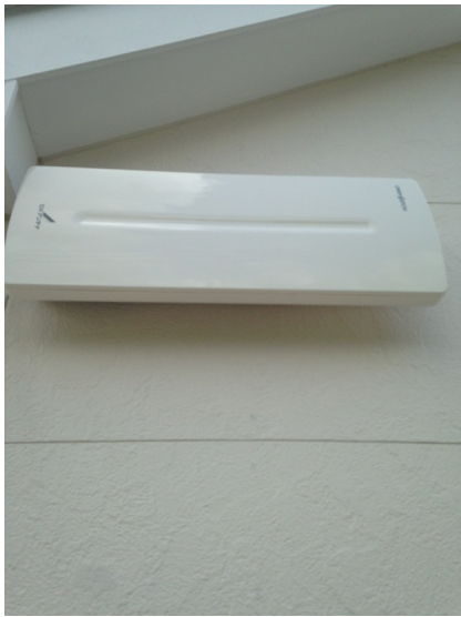
厚木市毛利台 アイディホーム様ご物件 垂直偏波受信 壁面取付 デザインアンテナ工事
