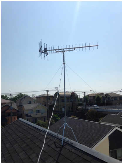
厚木市毛利台 クオリティオブラيف様ご物件 垂直偏波受信 地デジアンテナ屋根上工事
