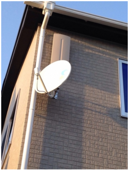
古河市松並 壁面取付 デザインアンテナとBSアンテナ工事
